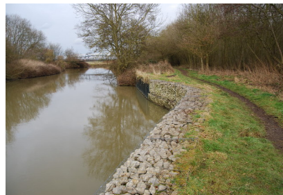
Figura 15.2.: Gabião vivo com vegetação emergente — a transição funcional da resistência mecânica para a ancoragem biológica.
