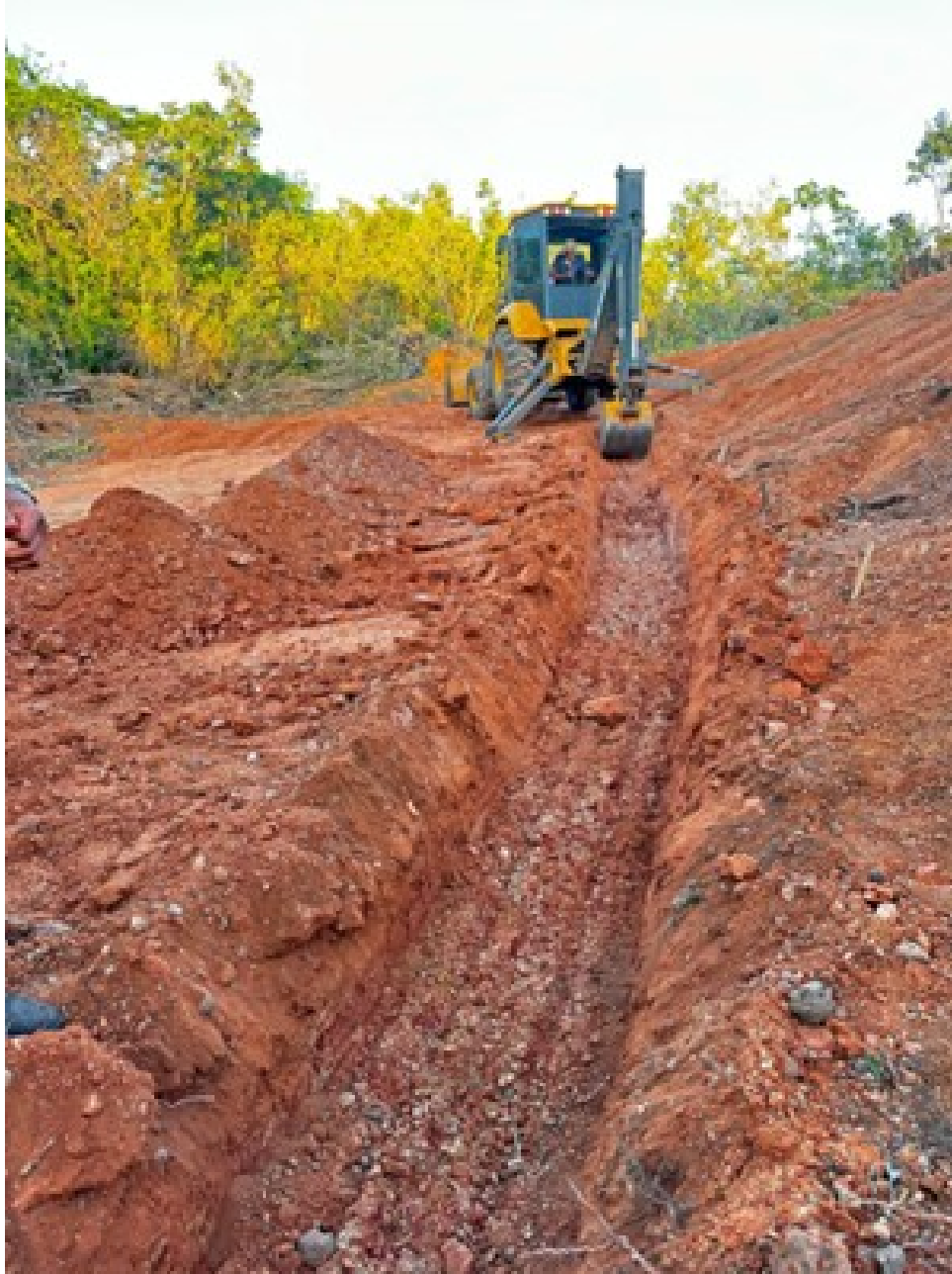
Figura 21.1.: Talude em campo antes da intervenção — superfície exposta susceptível à erosão laminar e concentrada, demandando reconfiguração geométrica e revegetação para estabilização.
