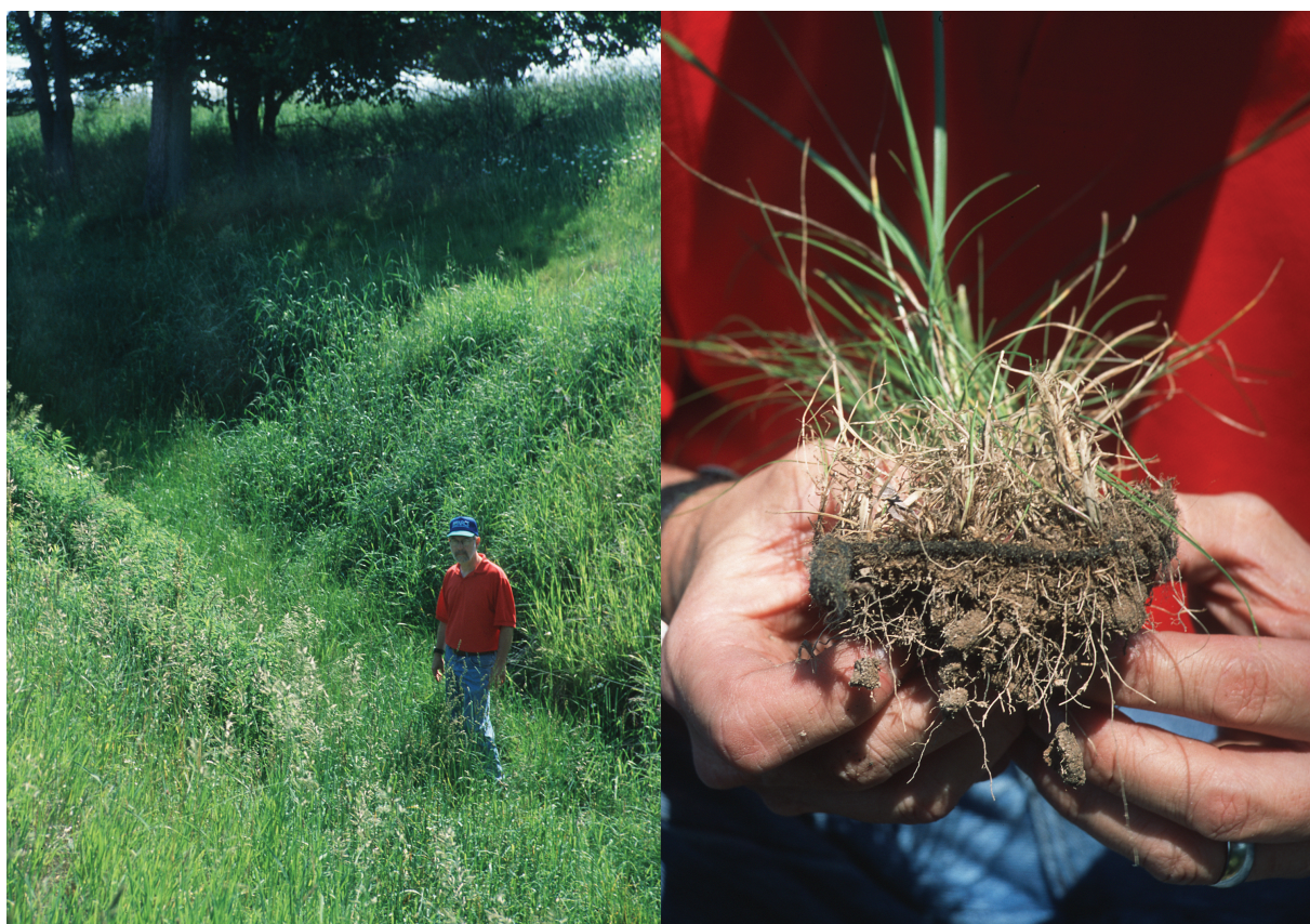
Figura 12.1.: Biomanta instalada em talude — proteção imediata contra erosão enquanto a vegetação se estabelece.
