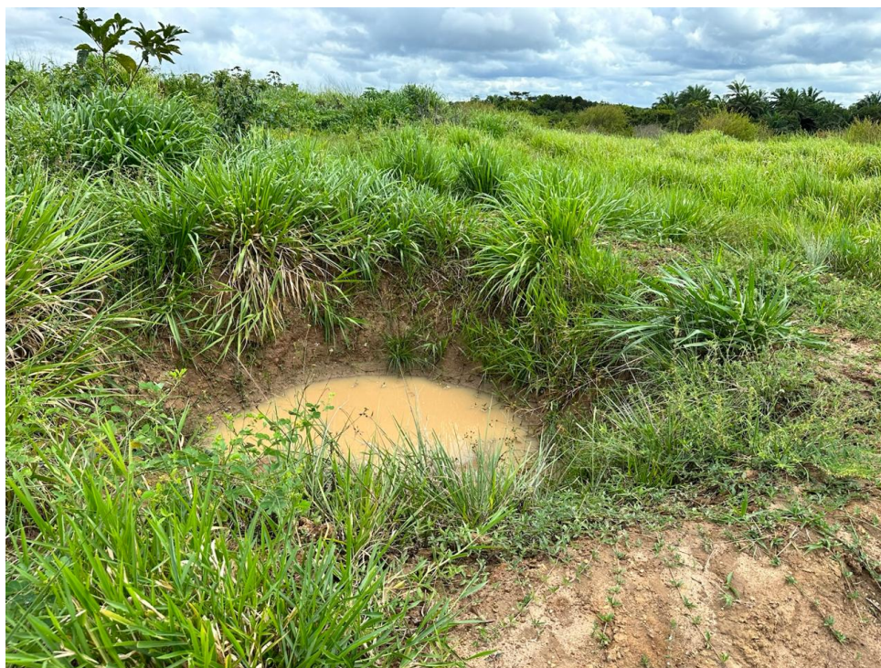
Figura 9.1.: Barraginha implantada em estrada rural — estrutura de retenção que intercepta e infiltra o escoamento superficial.
