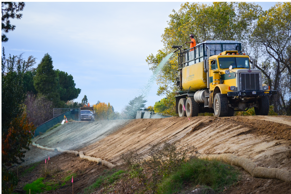
Figura 11.1.: Aplicação de hidrossemeadura em talude rodoviário — projeção mecanizada da pasta com sementes, mulch e fertilizante.
