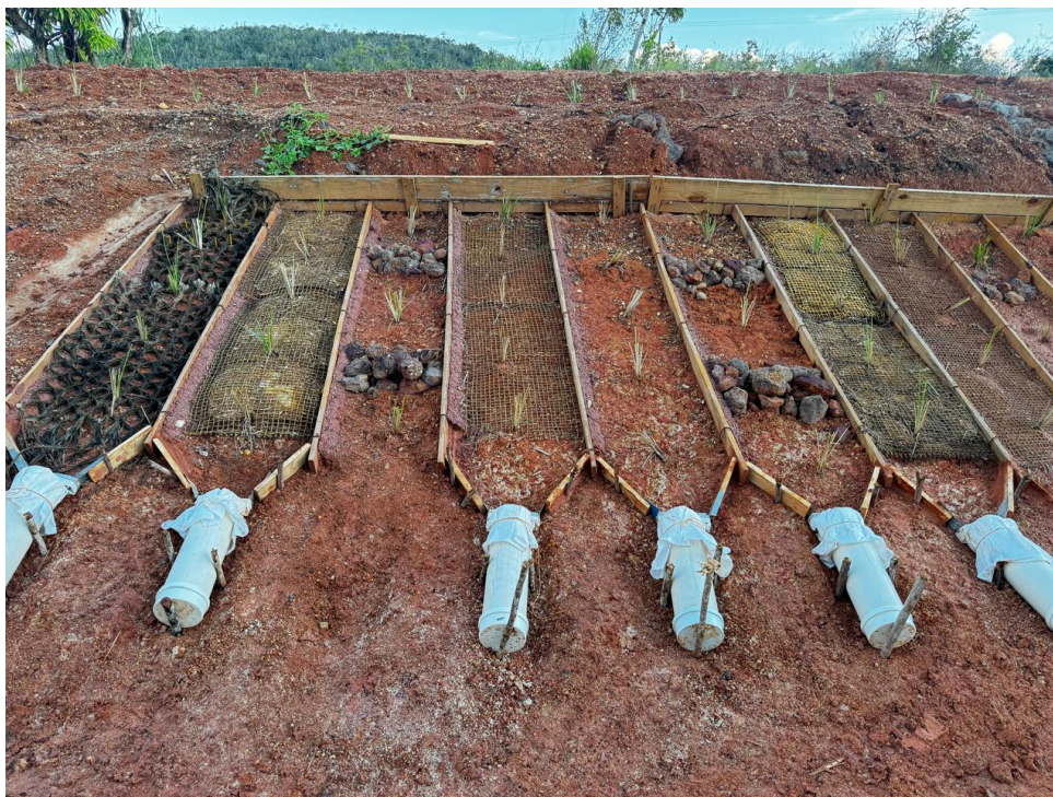
Figura 18.1.: Talude revestido com geotêxtil — o material têxtil protege o solo contra erosão enquanto permite o crescimento da vegetação através da sua estrutura permeável.
