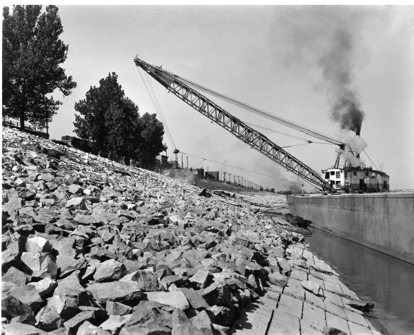
Figura 13.1.: Enrocamento em margem fluvial — pedras protegem a base enquanto a vegetação se estabelece entre os interstícios. — Figura 13.2.: Enrocamento vegetado — combinação de proteção mecânica e biológica em estágio avançado de consolidação.
