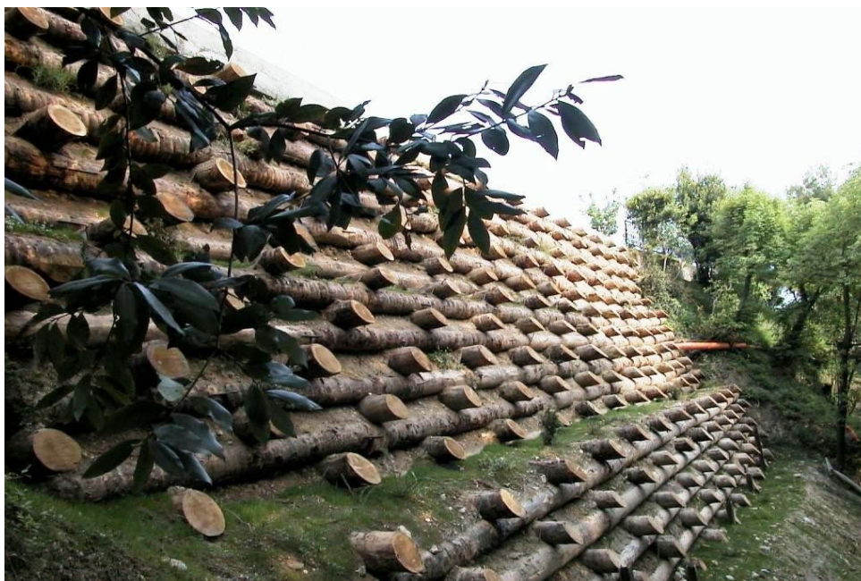
Figura 16.1.: Parede Krainer instalada — grelha de troncos preenchida com solo e vegetação para contenção de encostas.
