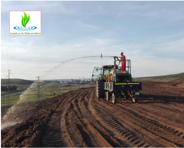
Figura 11.2.: Hidrossemeadura em restauração de área degradada — projeção da pasta sobre superfície erodível.
