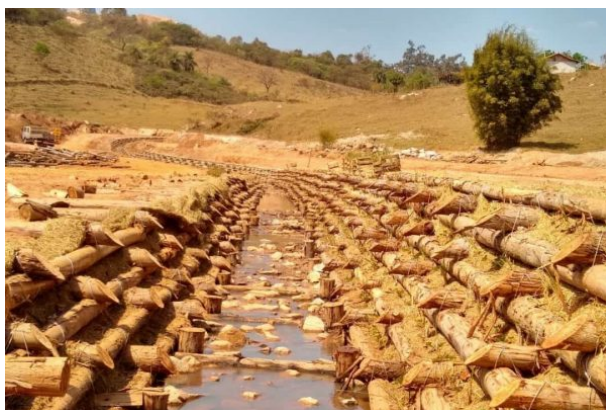
Figura 16.2.: Parede Krainer dupla em estágio avançado — vegetação já estabelecida entre os troncos.
